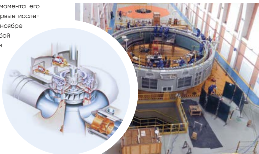
Генерирующая мощность генераторов на Белу-Монти составляет 679 МВА при весьма внушительном внутреннем диаметре статора 18,5 м.
