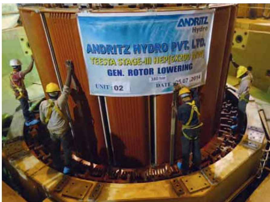
■ Einheben des Rotors von Maschinensatz #2
