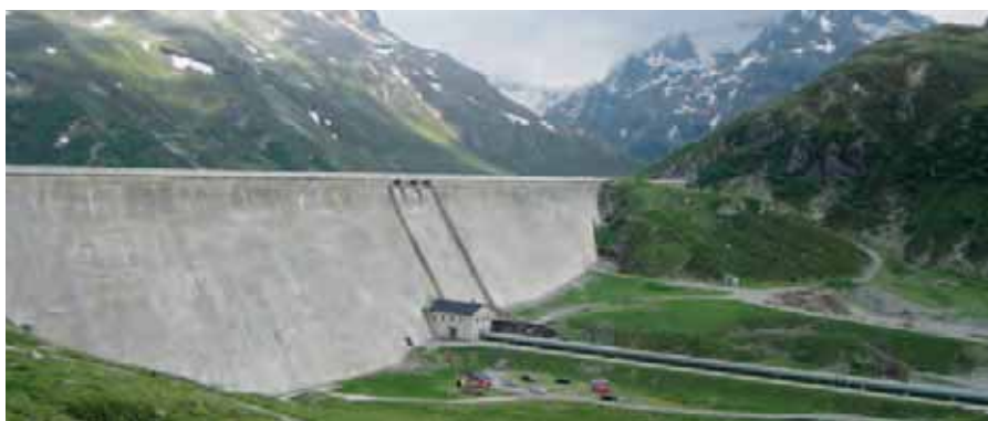
Silvretta Staumauer für WKW Obervermuntwerk II
