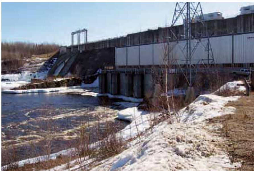
▼ Wasserkraftwerk Lower Mattagami
