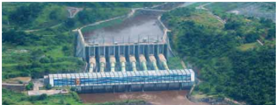
▣ Blick auf das Wasserkraftwerk Inga 2
