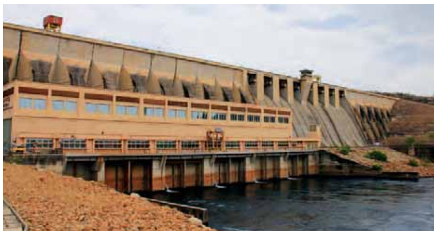
■ Anlage und Grundablass
