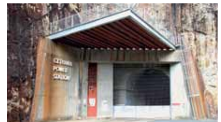
▲ Eingang zum Kraftwerkstunnel vom WKW Cethana
