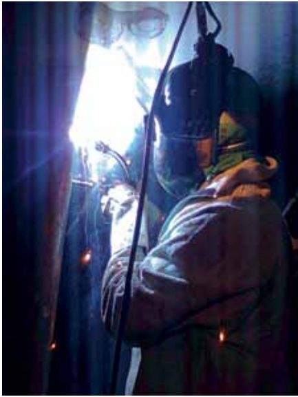
▲ Kavitationsservicereparatur im WKW Taquaruçu
