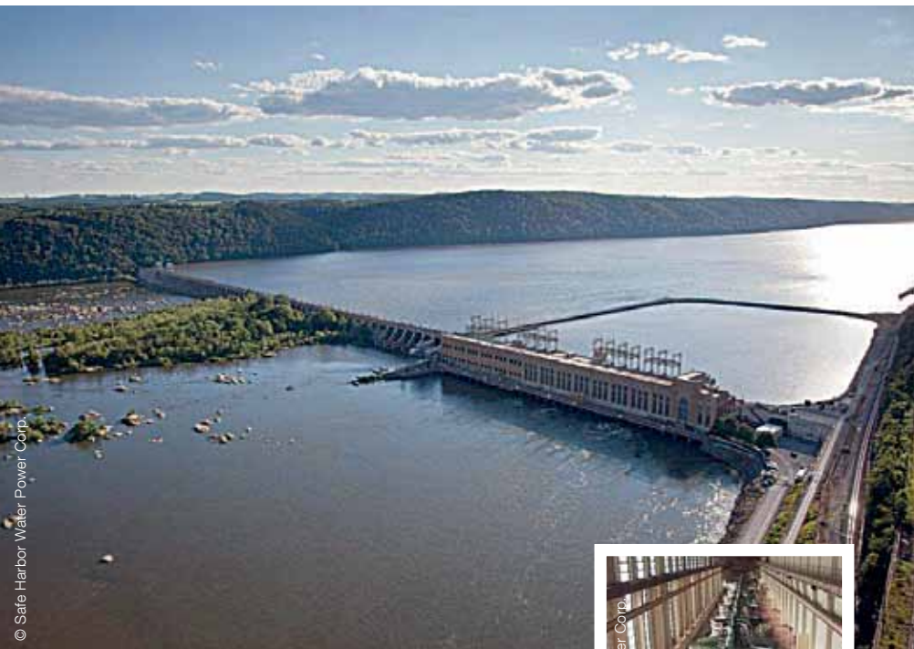
▲ Luftaufnahme des Wasserkraftwerks
