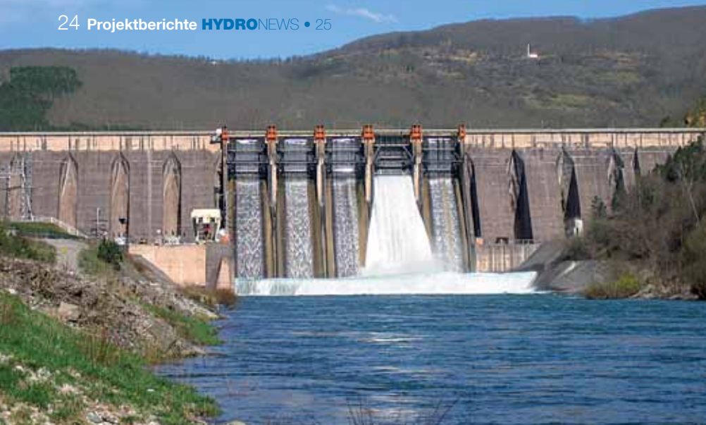
▲ Blick auf das Wasserkraftwerk Bajina Bašta
