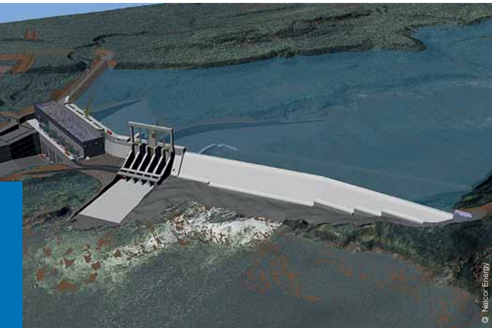
▲ Abbildung des Wasserkraftwerks Muskkrat Falls
