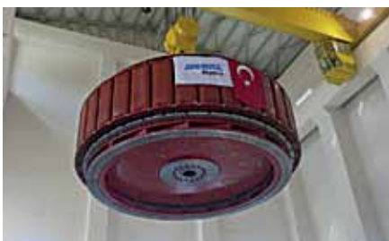
▼ Einheben des Rotors, Maschine 2
