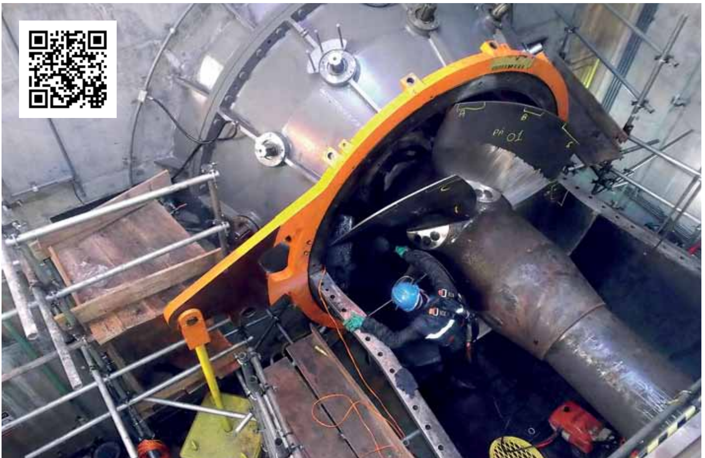
▼ Servicearbeiten am Kaplanlaufrad für das Projekt Mogi Guaçu
