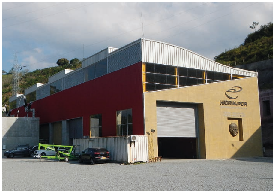
Casa de máquinas
