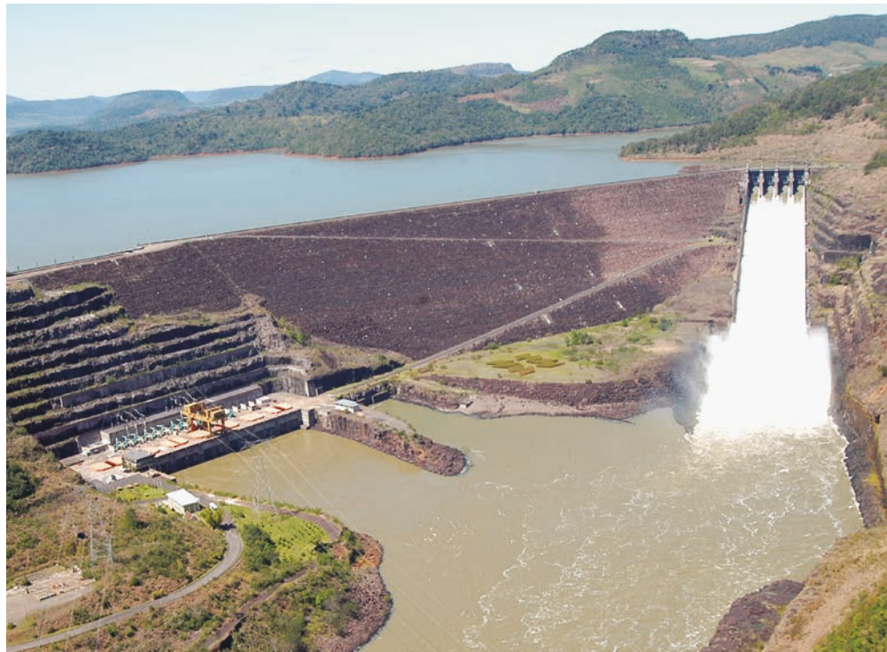
Vista aguas abajo de la casa de máquinas, presa y vertedero
