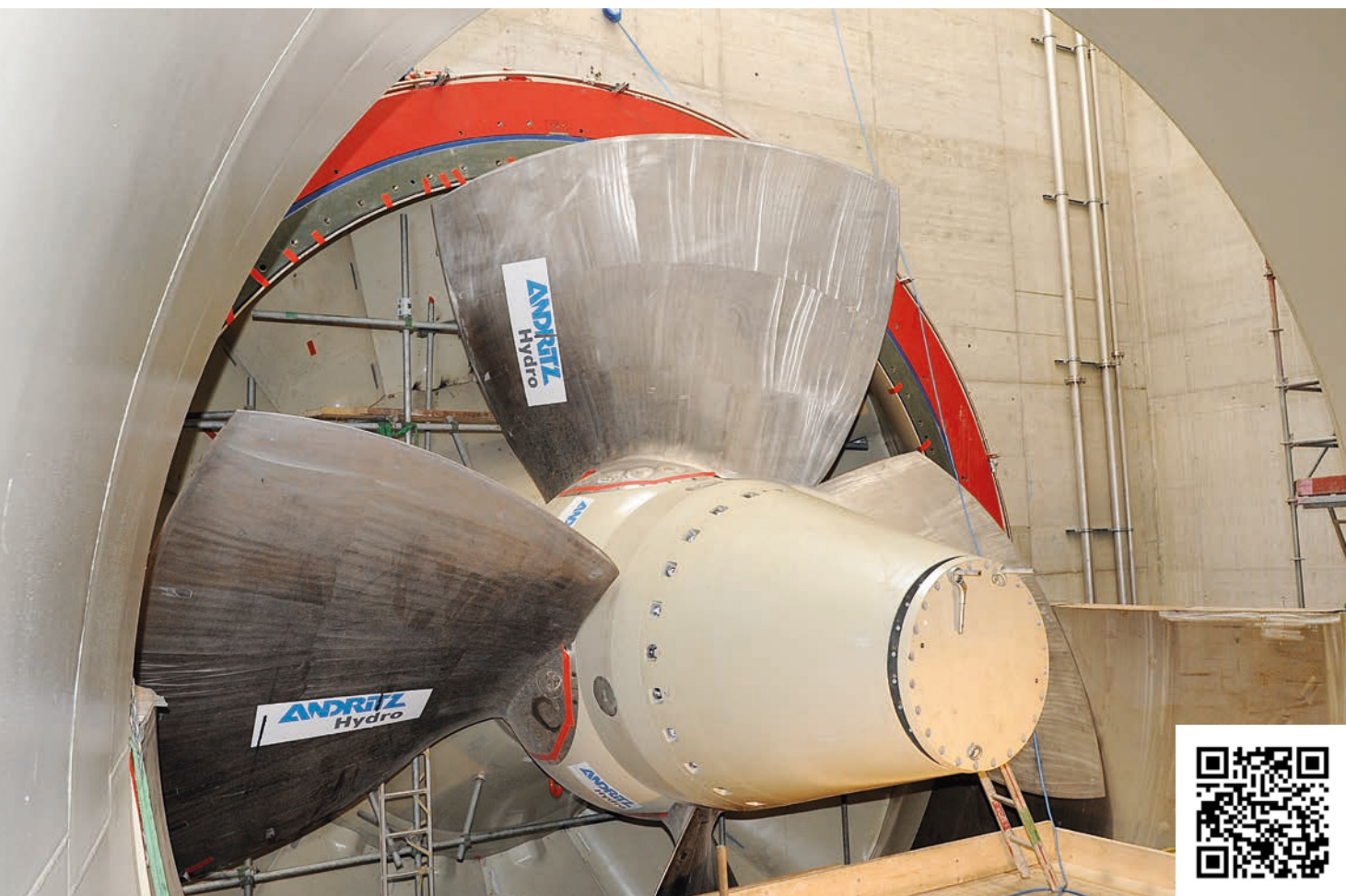
Rodete de turbina Bulbo durante el proceso de montaje en la CH Iffezheim, Alemania
