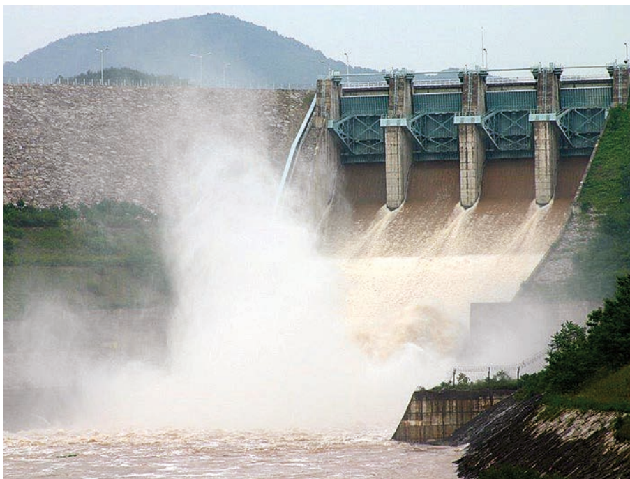
Presa y vertedero
