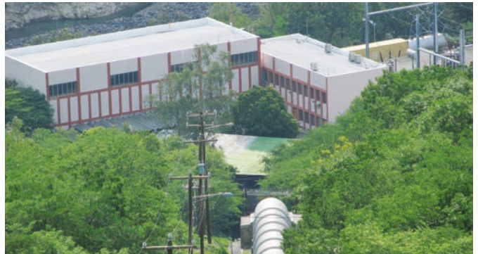
Casa de máquinas y tubería forzada existente en CH Carlos Fonseca
