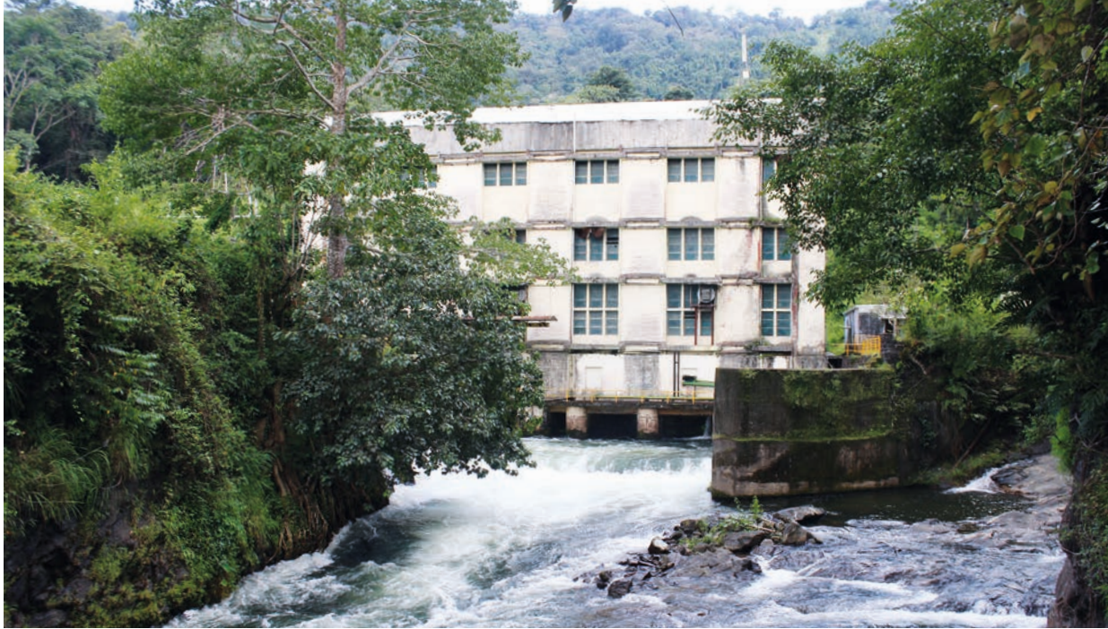
Casa de máquinas y Río Sholayar
