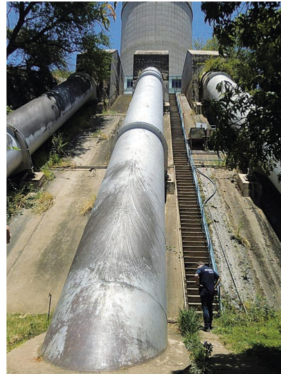
Tuberías antes de los trabajos de rehabilitación
