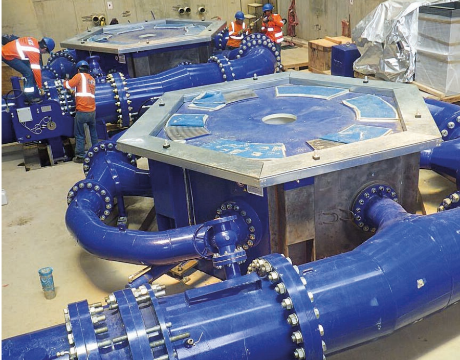
Montaje de las turbinas en CH El Carmen
