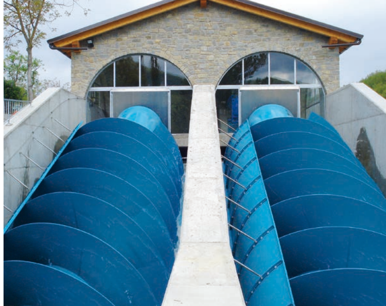
Turbinas tornillo hidrodinámico
