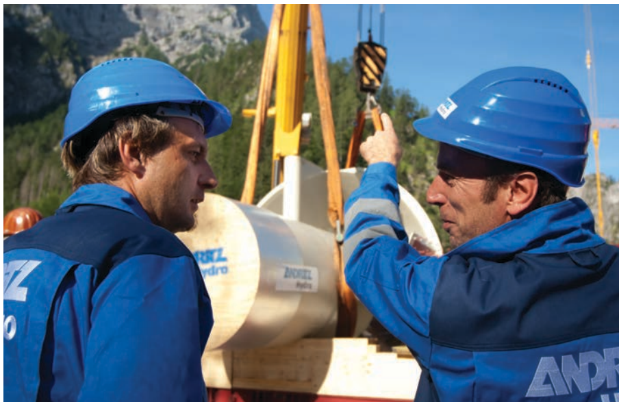
Trabajos de montaje de turbinas Bulbo
