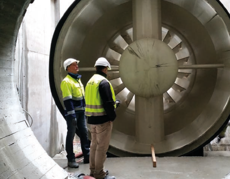
Trabajos de montaje de una pequeña turbina Bulbo
